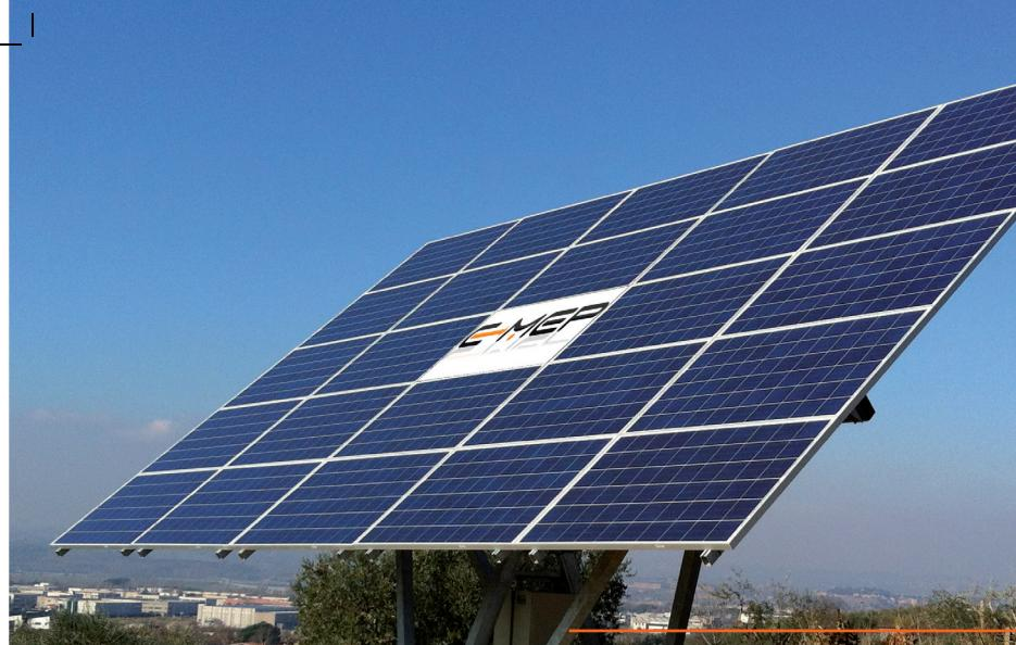
▲ Studio di fattibilità, analisi economica, progettazione, realizzazione e allaccio di un sistema solare fotovoltaico ad inseguimento da 6 kW.
